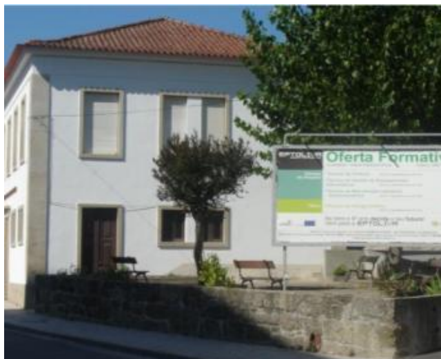
Figura 46. Vista do edifício do Pólo da EPTOLIVA em Tábua. Fonte: Eptoliva.
