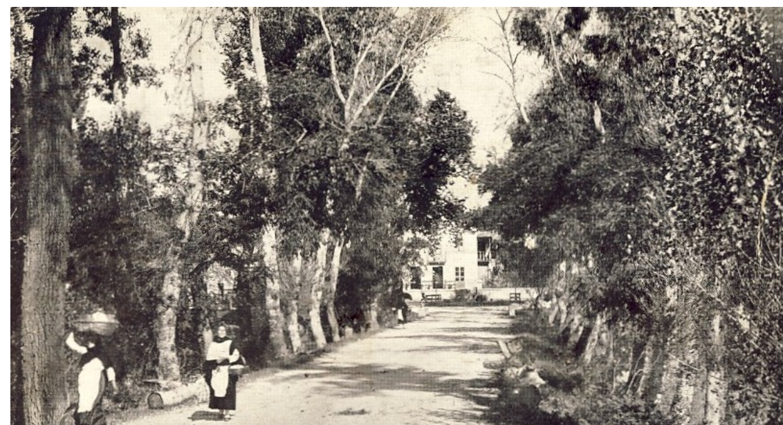
11 | Tábua - Alameda, entrada para a vila pelo lado sul
