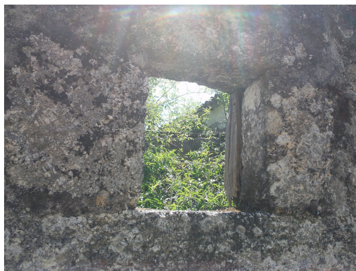
71 | Edifício sem caixilharia
