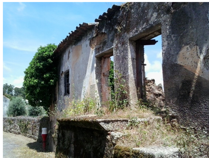
59 | Cobertura colapsada
