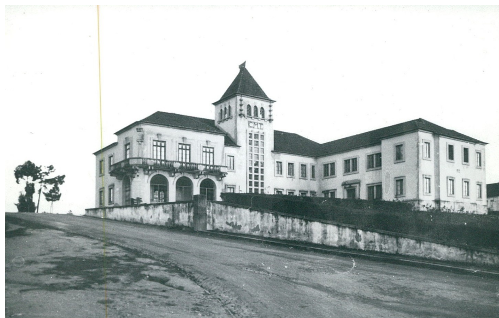
12 | Tábua - Edifício dos Paços do Concelho
