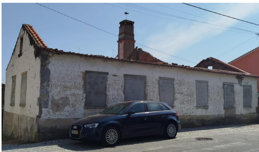
Figura 32. Cobertura colapsada
