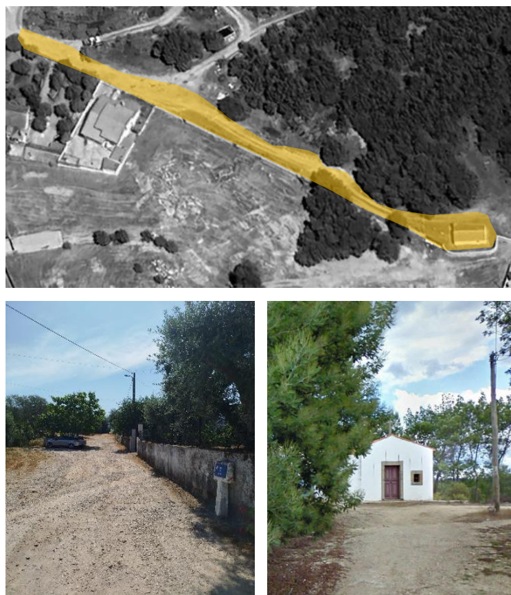
Figura 50. Localização da Capela de São João
