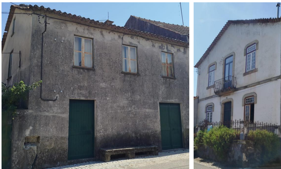
Figura 37. Caixilharias degradadas
