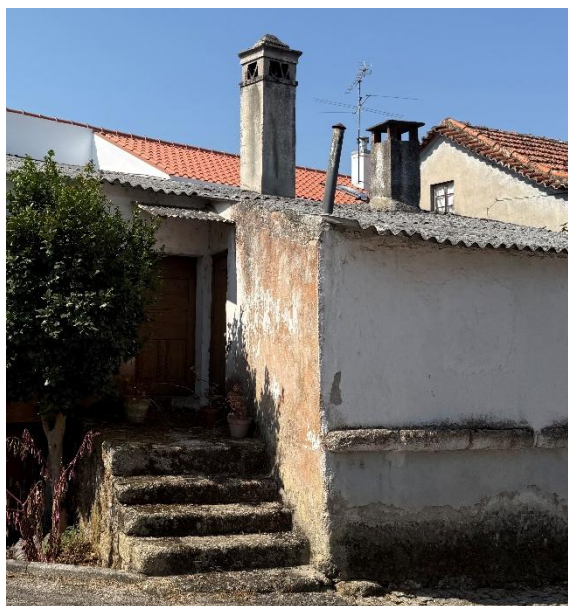
Figura 31. Cobertura deformada
