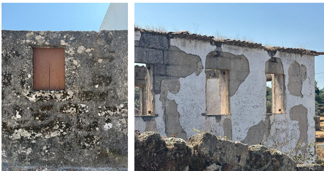
Figura 38. Edifícios sem caixilharia
