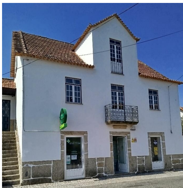
Figura 26. Edifício com piso de comércio (farmácia)
