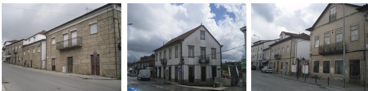
Figura 5. Conjuntos de edifícios na rua Dr. Francisco Beirão e Rua José dos Santos Gonçalves, vila de Tábua
