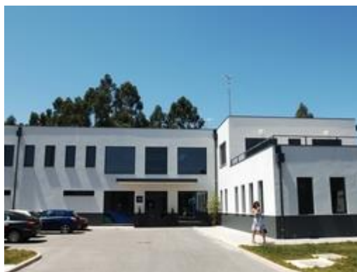
Figura 37. Estação de Tratamento de Água (ETA)
