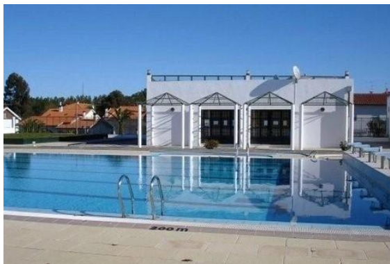
Figura 25. Piscina Municipal de Tábua (exterior)
