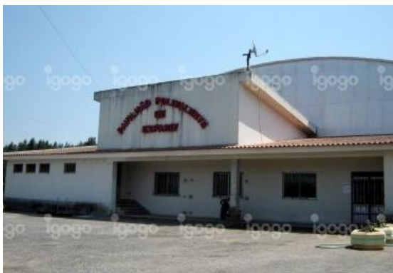
Figura 22. Pavilhão Polivalente de Espariz
