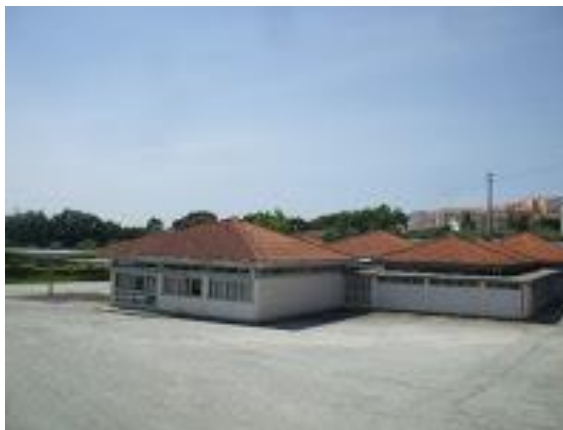
Figura 3. Creche SCM de Tábua
