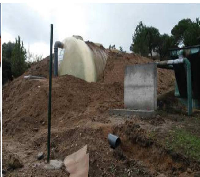
Ampliação e Beneficiação da Rede de Saneamento
