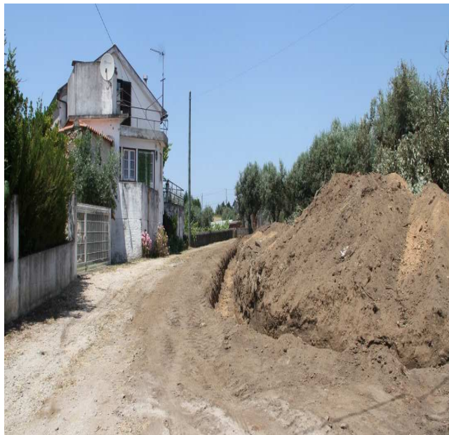
Beneficiação e Reparação da Rede Viária
