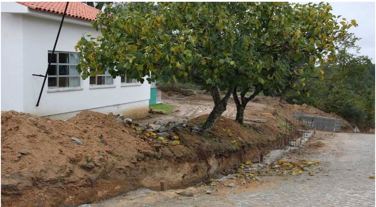
Construção do Muro de Vedação
