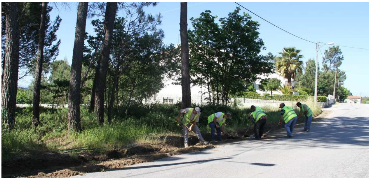
Limpeza de Bermas e Valetas
