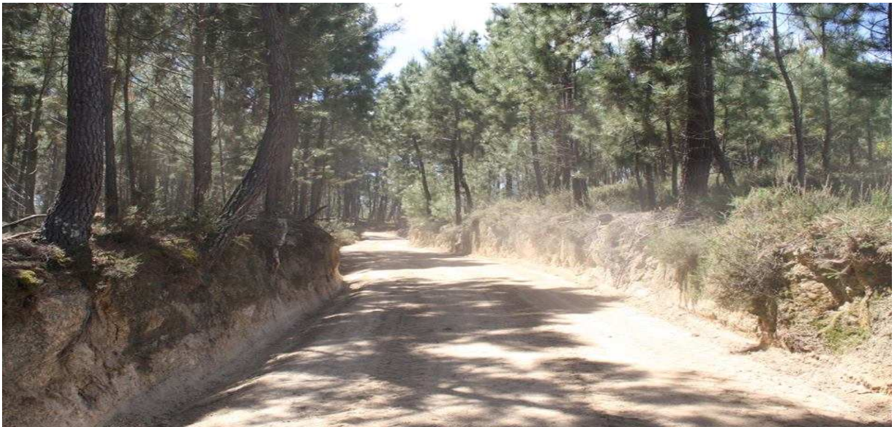
Correção de Plataforma e Drenagem das Águas Pluviais em Caminho Público.
