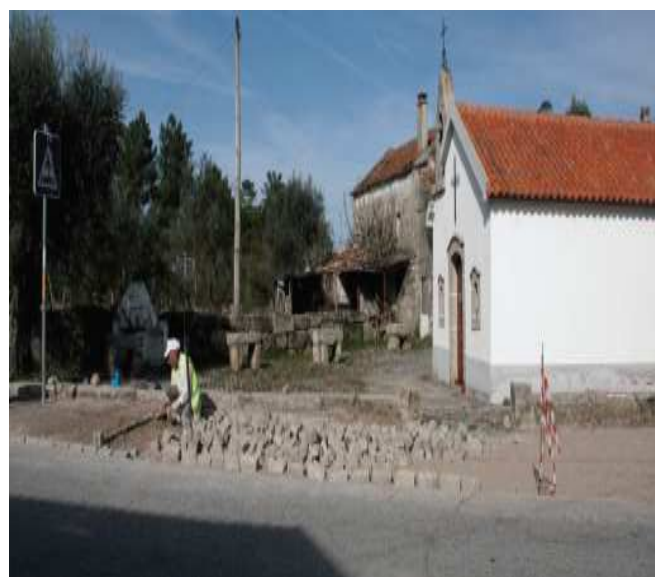
Construção de Passeios
