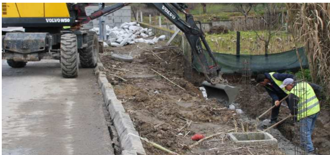
Construção de Muros e Passeios
