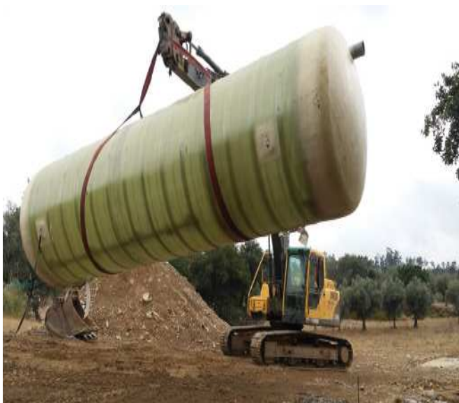
Ampliação e Beneficiação da Rede de Saneamento
