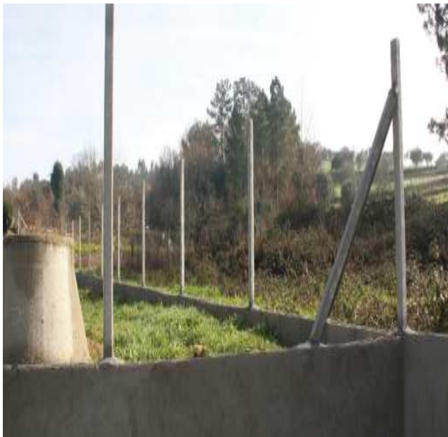
Construção do Muro de Vedação da ETAR
