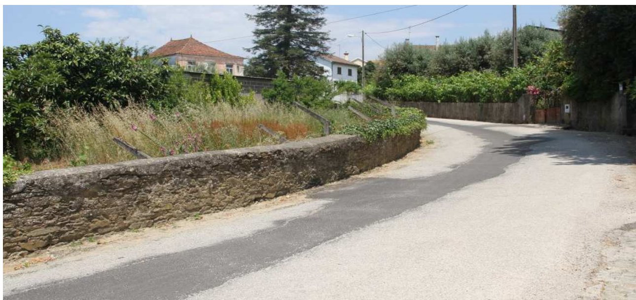
Pavimentação das Valas de Saneamento
