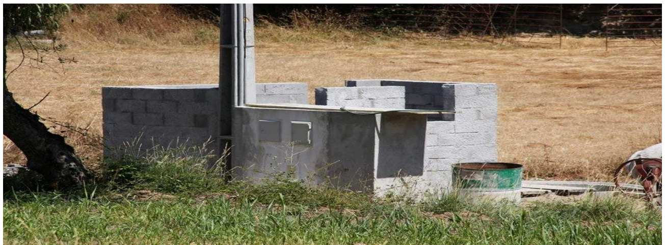
Proteção da Estação Elevatória de Águas Residuais
