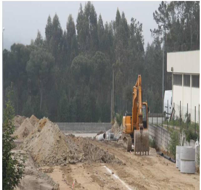
Construção de Novos Acessos ao Parque Industrial
