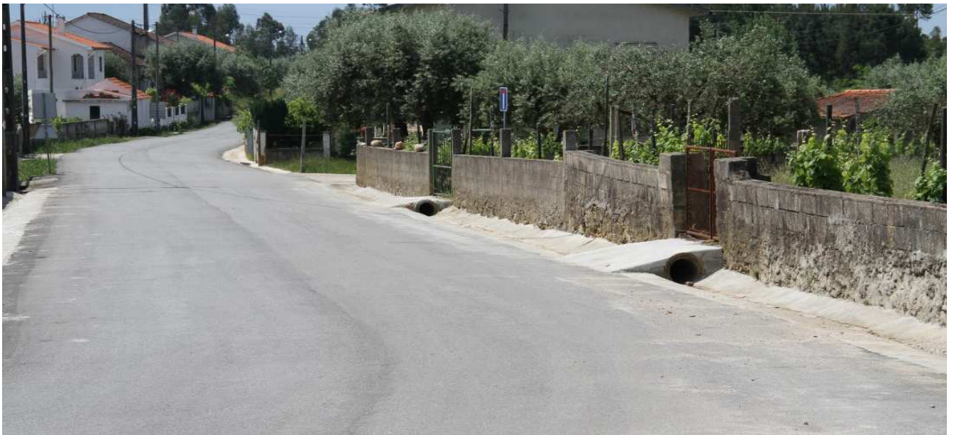
Execução de Valetas
