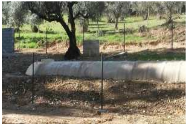
Criação e Beneficiação da Rede Saneamento do Covelo
