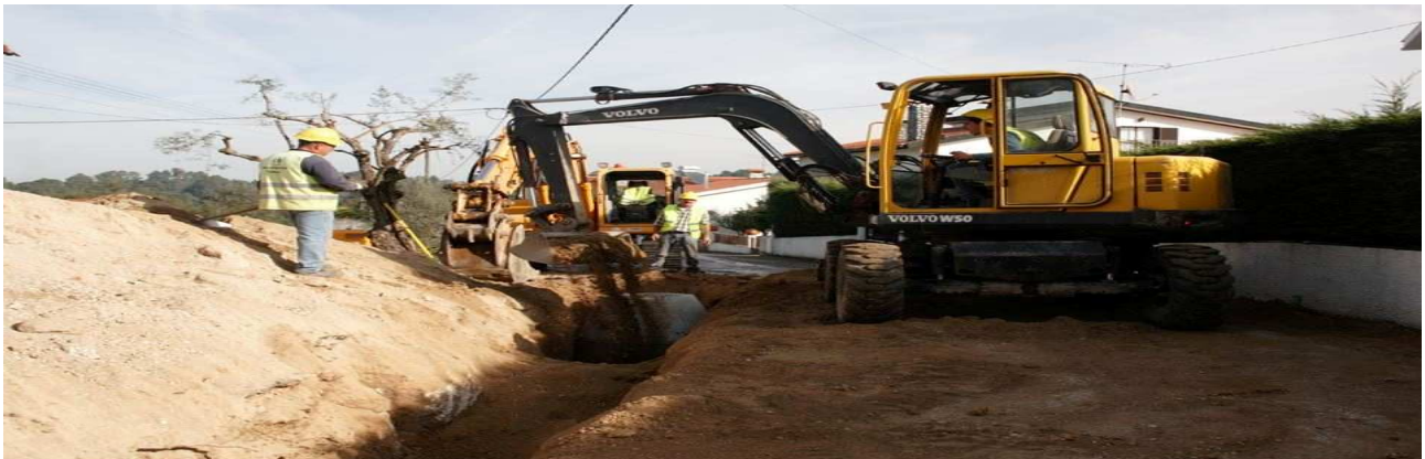
Ampliação e Beneficiação da Rede de Saneamento
