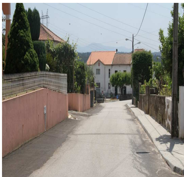
Construção de Passeios e Rede de Águas Pluviais
