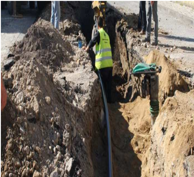
Requalificação da Rede de Drenagem de Águas Pluviais
