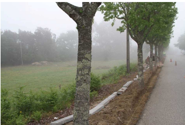
Construção de Passeios em Ázere
