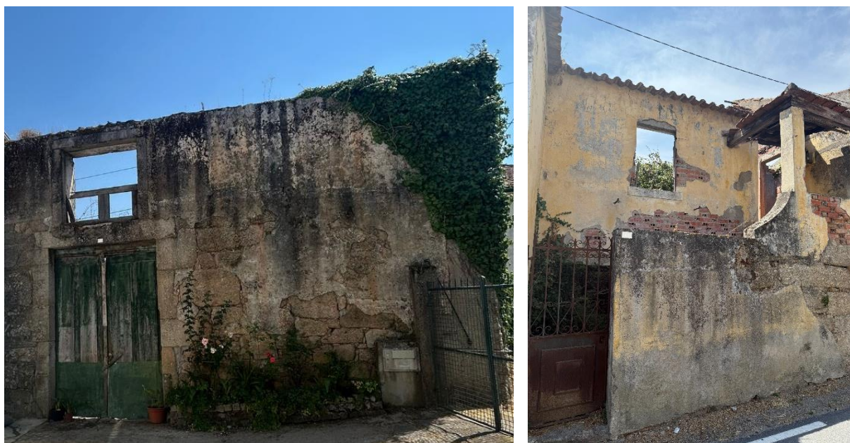
Figura 35. Coberturas colapsadas
