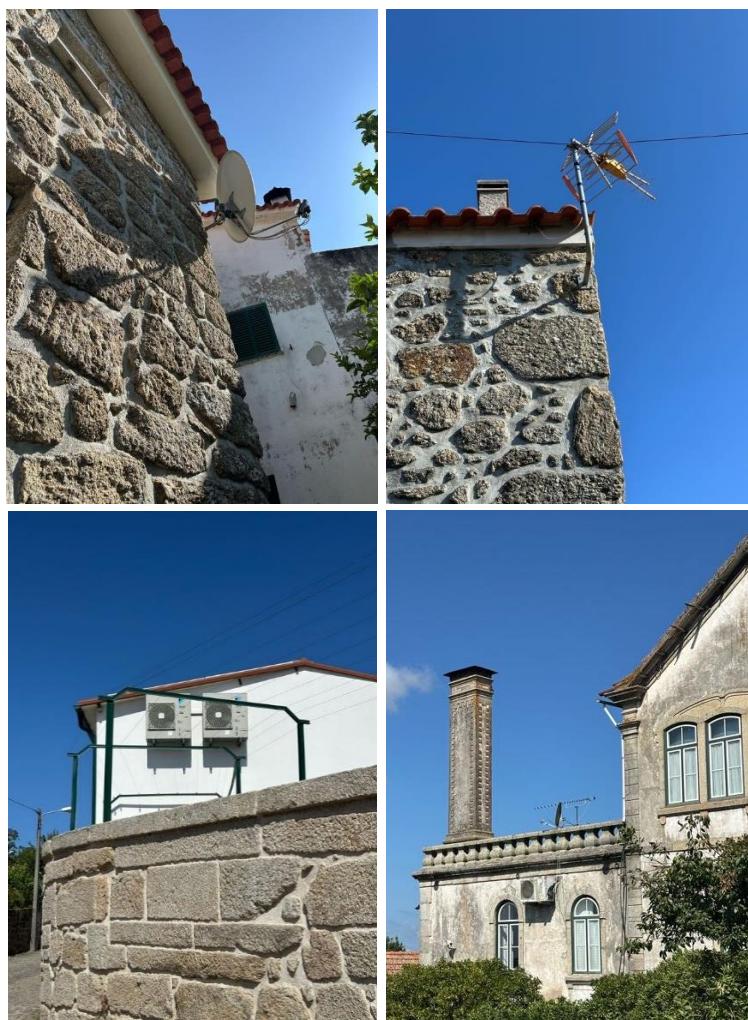
Figura 39. Presença de máquinas de AC e antenas de televisão
