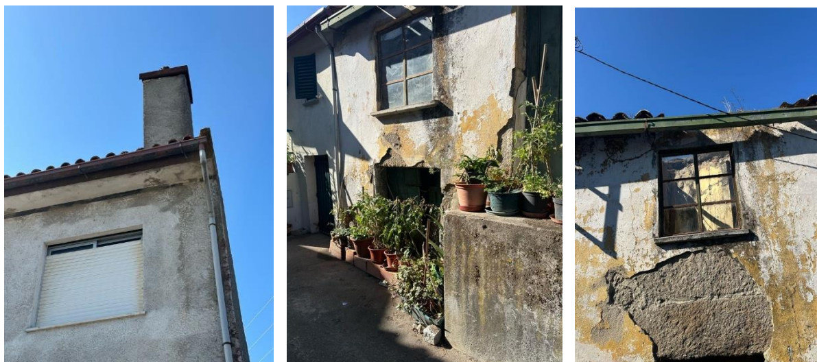
Figura 40. Caixilharias degradadas
