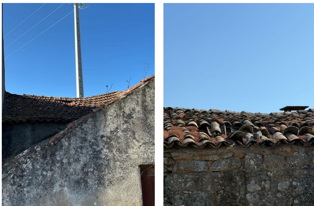
Figura 34. Coberturas deformadas
