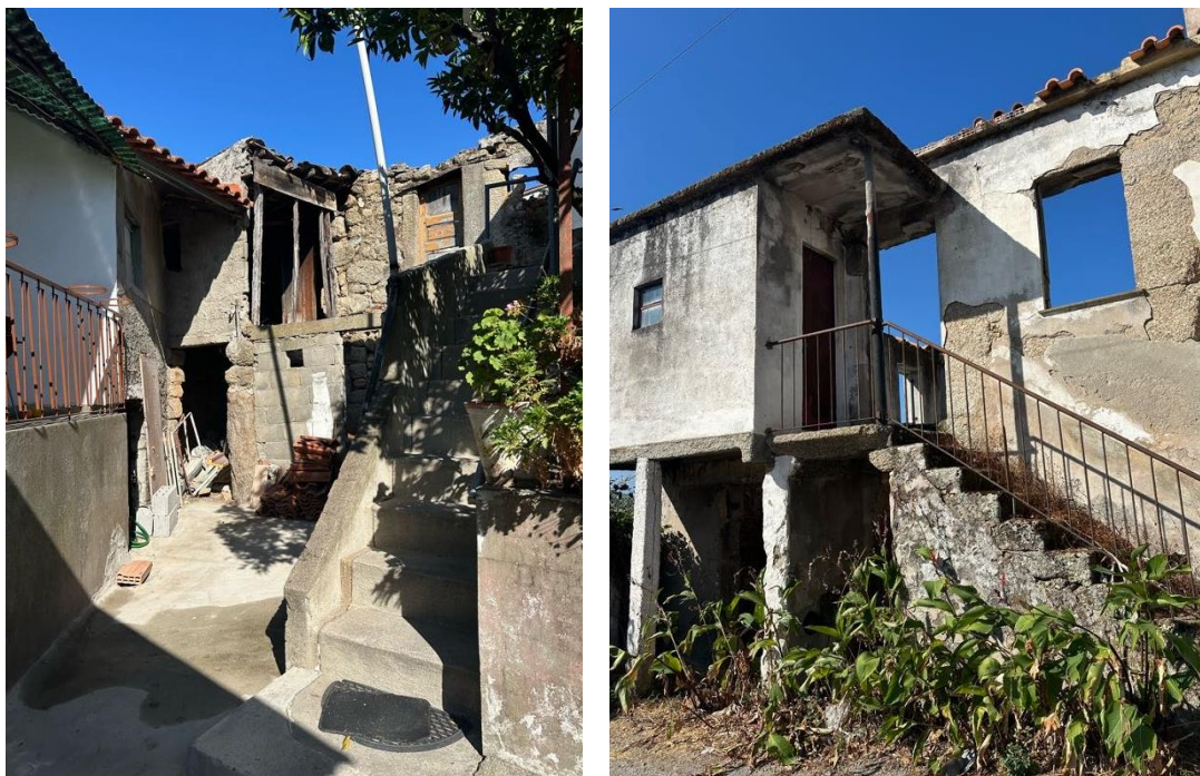
Figura 56. Situação existente do edificado no aglomerado urbano de Vasco
