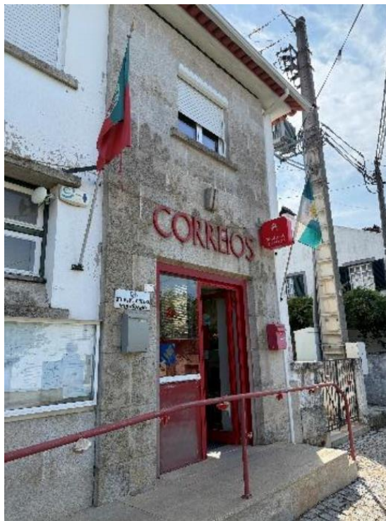
Figura 24. Estação dos Correios de Mouronho
