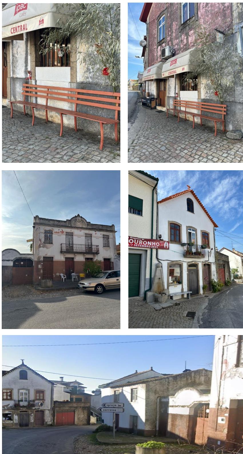
Figura 61. Edificado no troço a requalificar na EN 337
