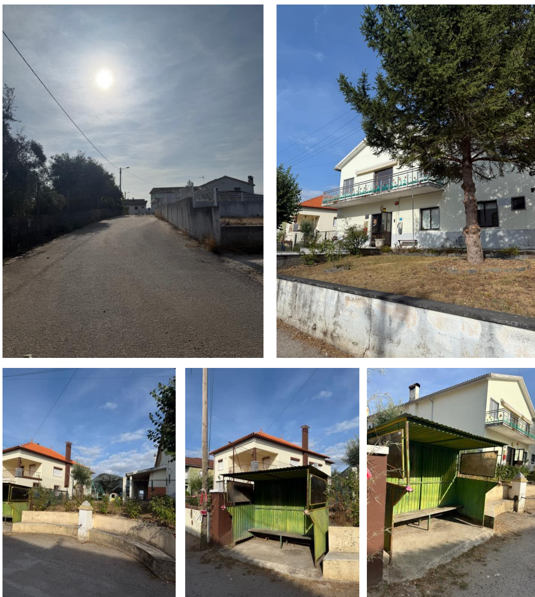
Figura 60. Espaço público na EN 337, Centro Social e mobiliário urbano
