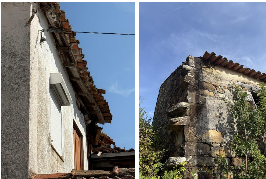
Figura 38. Coberturas deformadas
