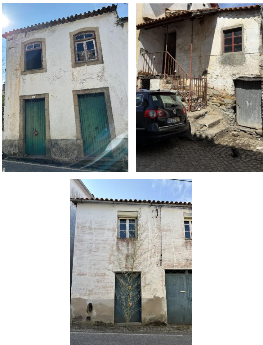
Figura 44. Caixilharias degradadas
