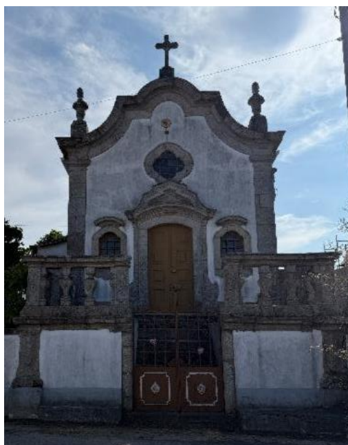
Figura 22. Capela de Nossa Senhora da Conceição
