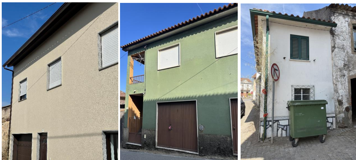
Figura 37. Coberturas com caleira
