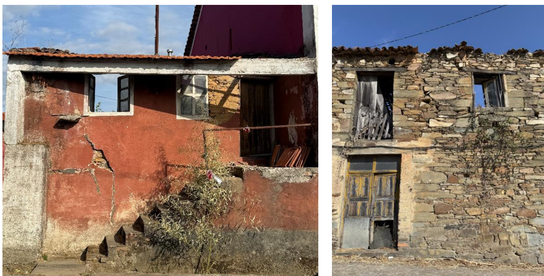
Figura 39. Coberturas colapsadas
