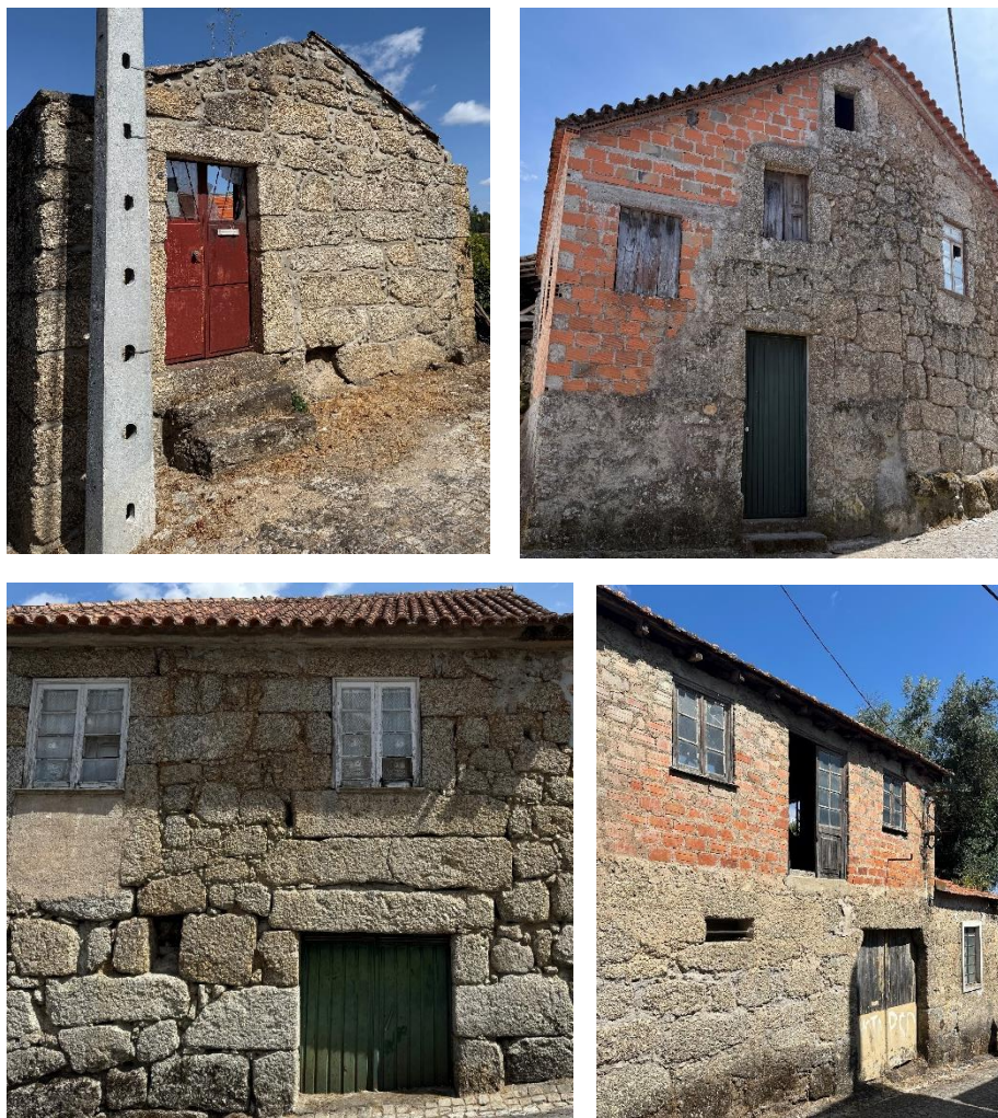
Figura 37. Caixilhariias degradadas
