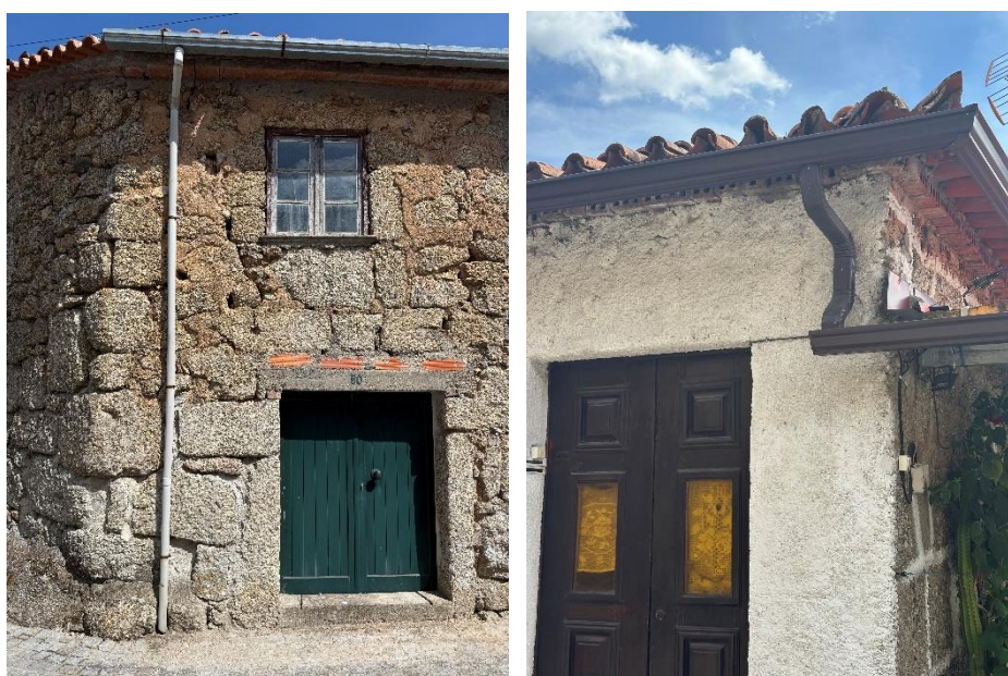
Figura 30. Exemplo de cobertura com caleira
