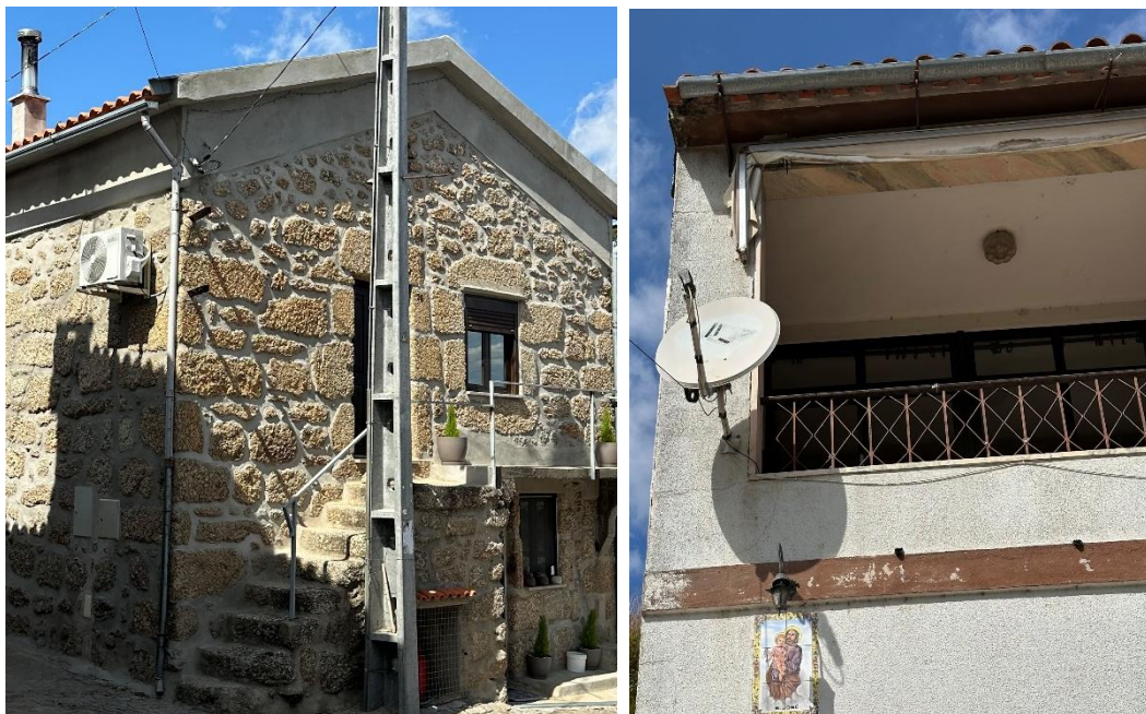
Figura 36. Presença de máquinas de AC e antenas de televisão
