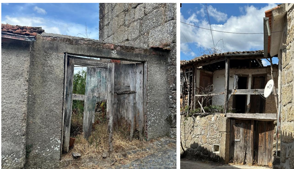
Figura 32. Coberturas colapsadas
