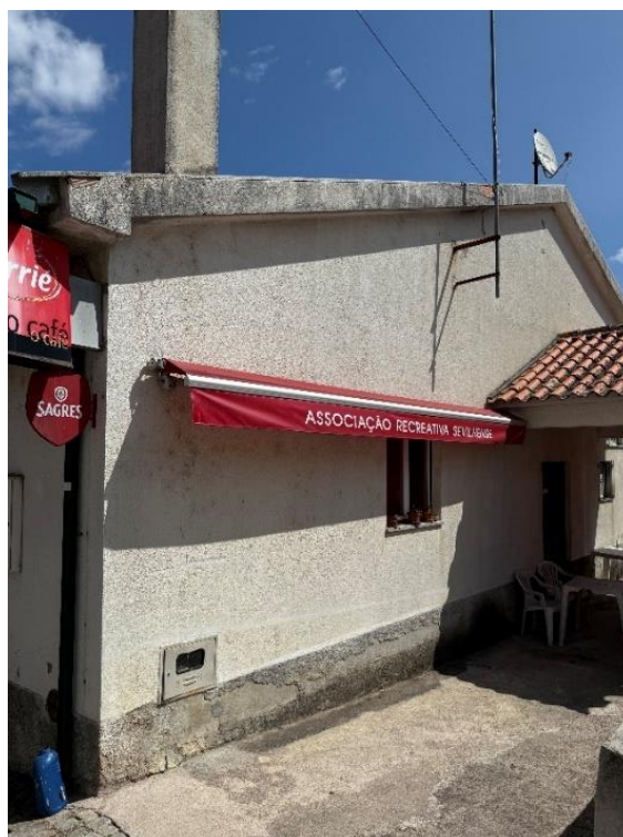
Figura 25. Edifício com piso de comércio – Associação Recreativa Sevilhense
