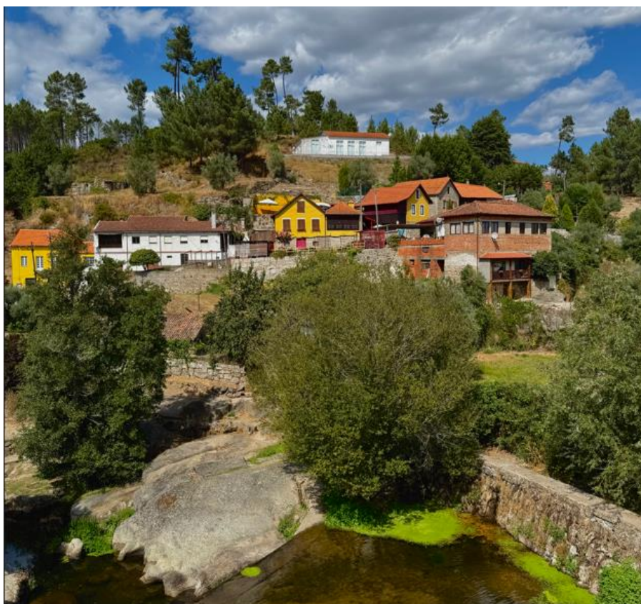
Figura 55. Fachada edificada na rua da Foz
